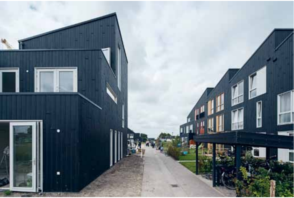
De paden door de collectieve buitenruimte zijn eigendom van de gemeente en liggen boven de kabels en leidingen.
