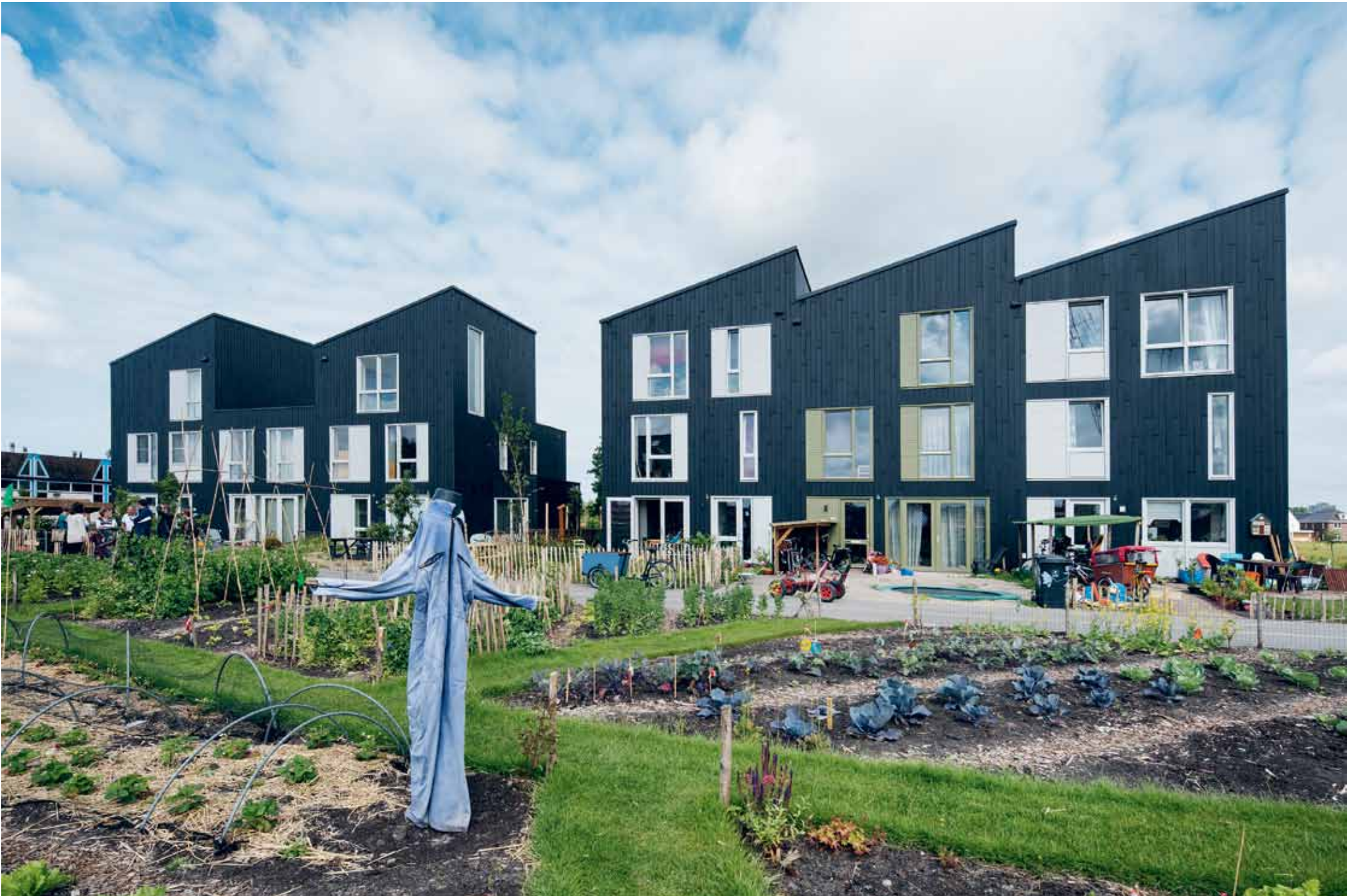
De gevels zijn gemaakt van zwart gerecycled kunststof met een houtstructuur, als verwijzing naar de landbouwschuren in de omgeving. Bewoners bepaalden zelf de kleur en de positie van de ramen.
